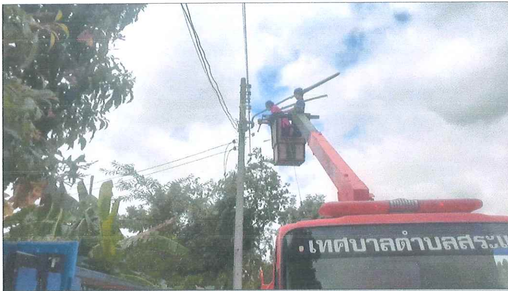
๑.๕ กองช่าง เทศบาลตำบลสระแก้ว ออกให้บริการซ่อม/เปลี่ยนหลอด ไฟฟ้าสว่าง ในเขตพื้นที่ เทศบาลตำบลสระแก้ว
